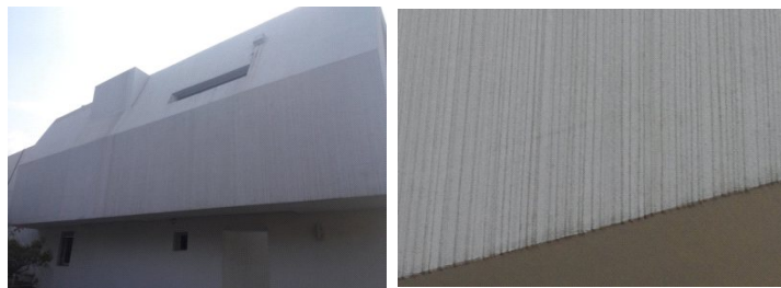
<그림 6-13> 외단열미장마감공법의 경사벽 적용으로 인한 오염
