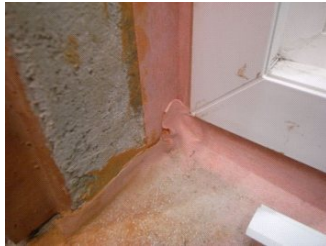
<그림 6-21> 창호주변의 기밀테이프 시공
