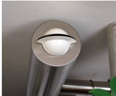
<그림 6-41> 코안다효과 디퓨저 <그림 6-42> TAB 시험
