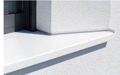
<그림 6-10> 빗물받이 설치 예
