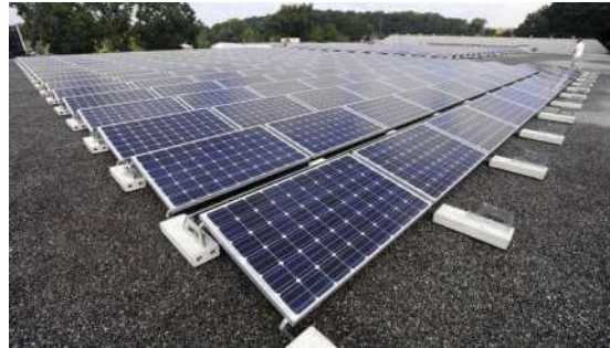
<그림 6-45> 평지붕 태양광발전패널의 설치
