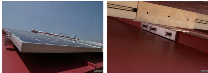
<그림 6-46> 경사지 5.47 봉용 전용 마운트를 이용한 태양광발전패널의 설치
