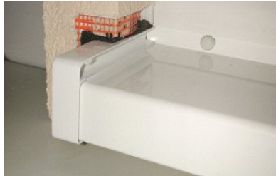
<그림 6-10> 빗물받이 설치 예
