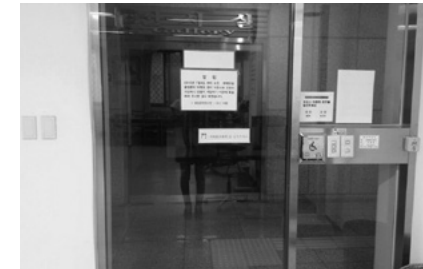
〈사진 3-9〉 자동문으로 설치된 출입구 (대구광역시립동부도서관)
