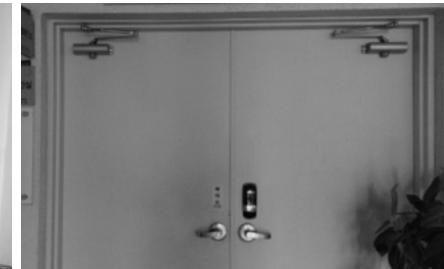
〈사진 3-10〉 철문으로 설치된 출입구 (고양시립백석도서관)
